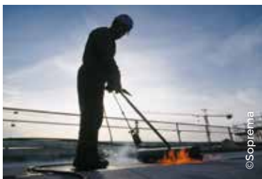
Soudure au chalumeau de membranes bitumeuses
