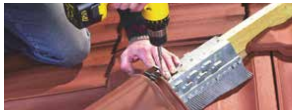
Pose à emboîtement fixé à sec
