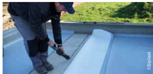
Auto-collage à froid de membranes bitumeuses
