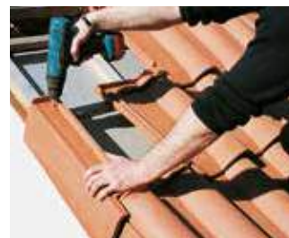
Rive individuelle : principe de pose
