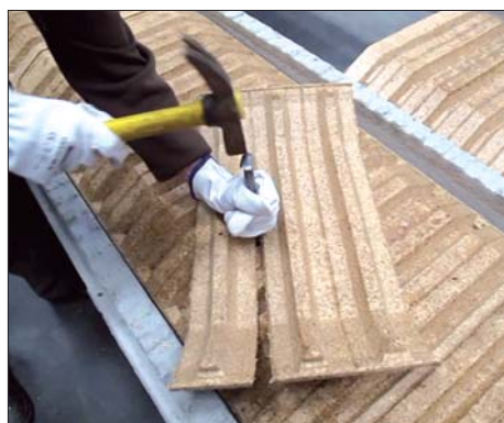
Coupe au burin ou au marteau (sécable)
