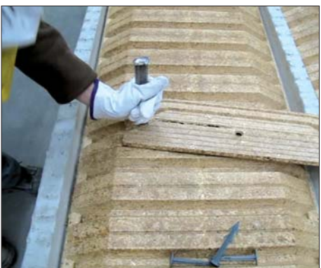
Séparation du tympan pour rupteur ES
