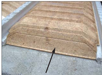
Bouchon incorporé et sécable
