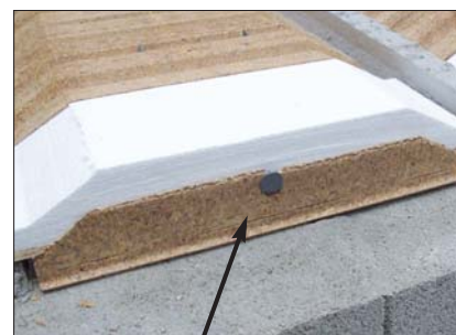
Tympans sécable incorporé dans le bouchon pour pose des rupteurs Stoptherm ES
